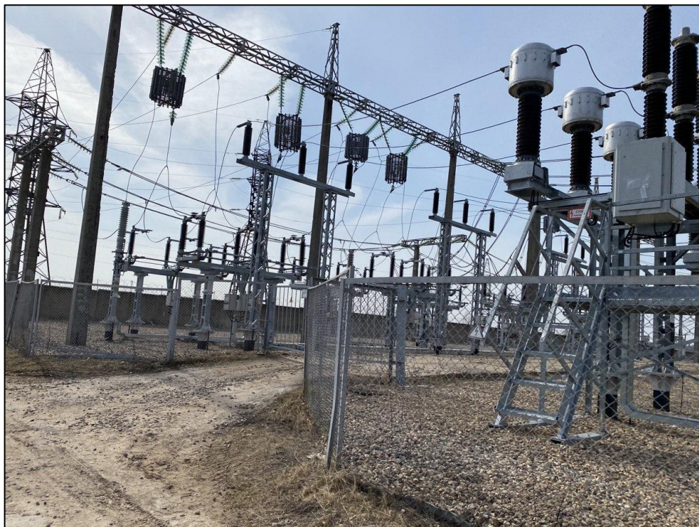
Рисунок 1 - Фото ОРУ 110 кВ (обследование объекта).
