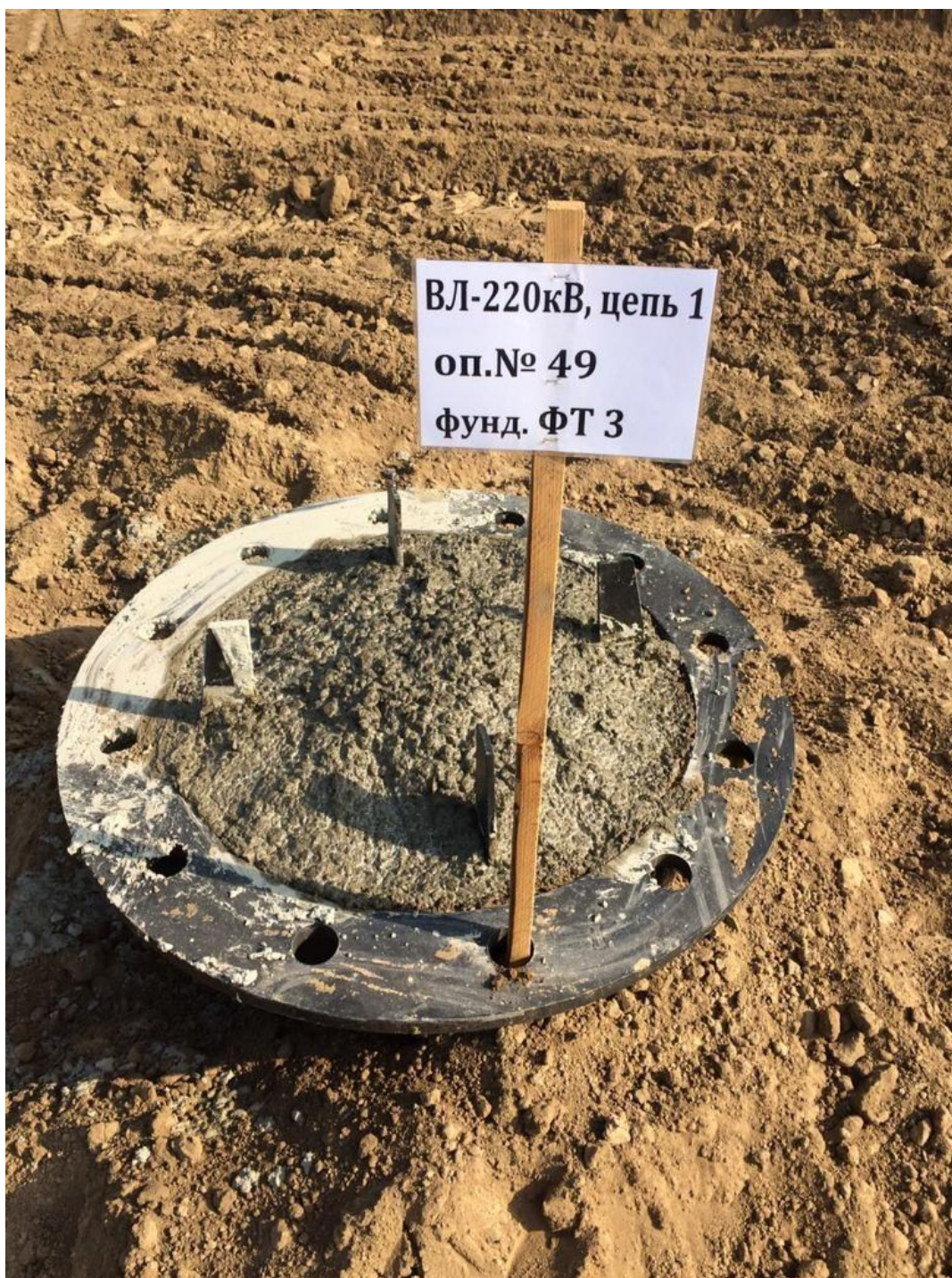
Рисунок 8 – Фундамент опоры ВЛ 220 кВ
