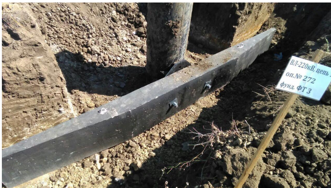
Рисунок 9 – Установка ригелей опоры ВЛ 220 кВ
