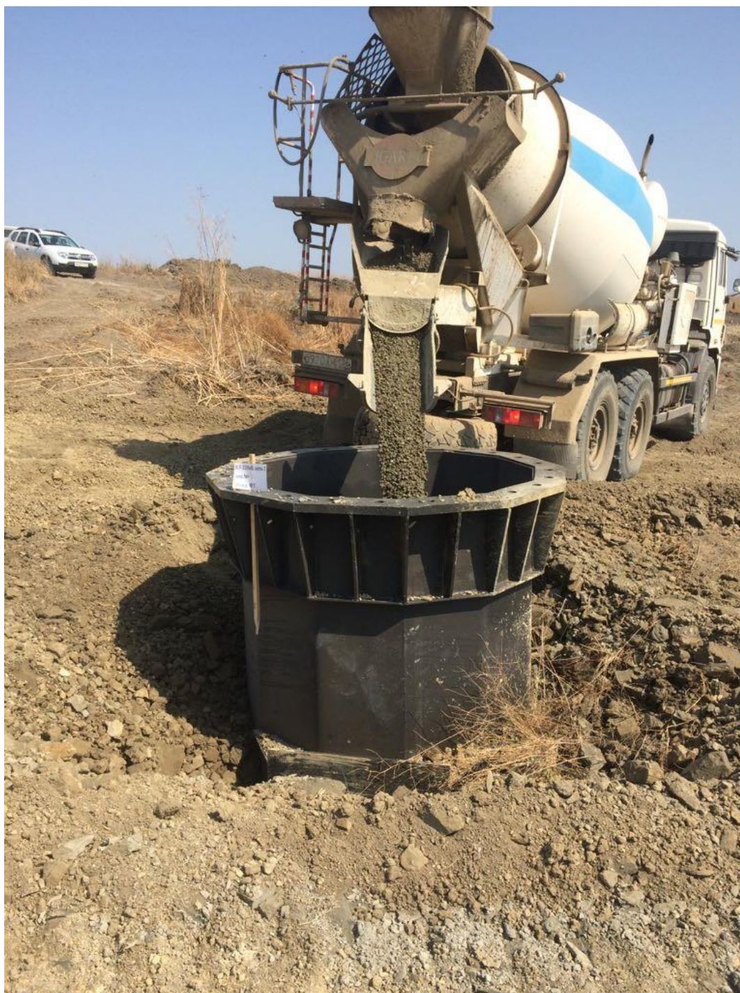
Рисунок 7 – Заливка бетона в основании опоры ВЛ 2200 кВ
