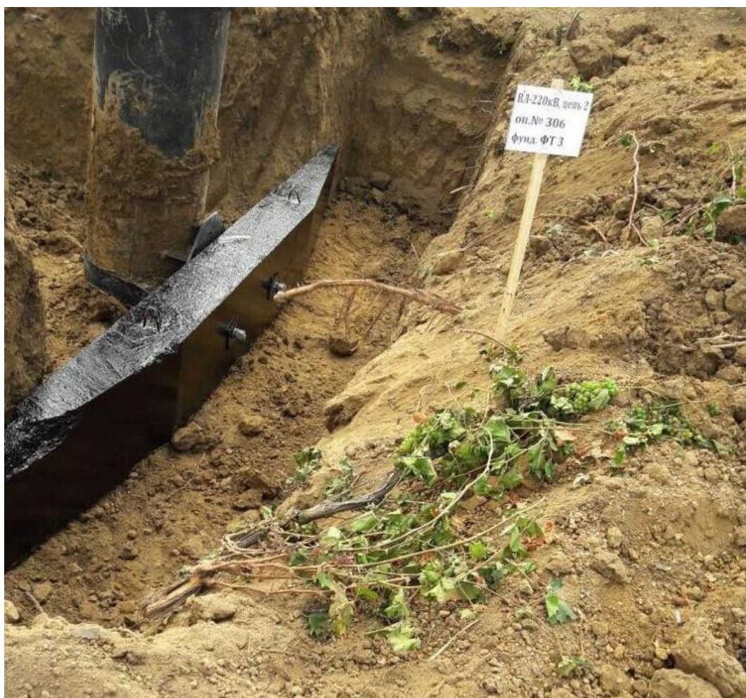
Рисунок 10 – Установка ригелей опоры ВЛ 220 кВ
