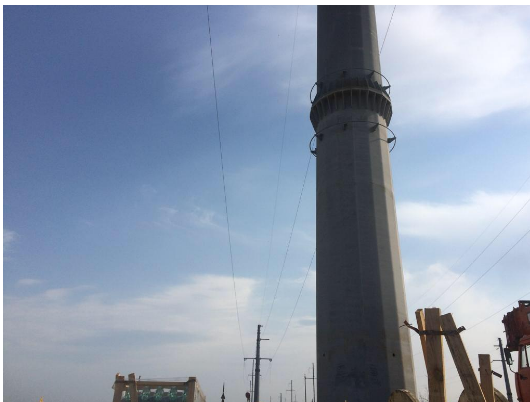
Рисунок 6 – Монтаж промежуточной опоры ВЛ 220 кВ
