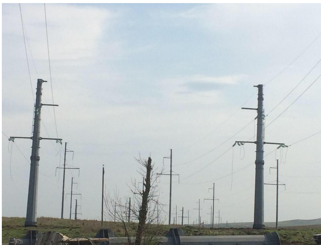
Рисунок 4 – Монтаж проводов ВЛ 220 кВ 1 и 2 цепь
