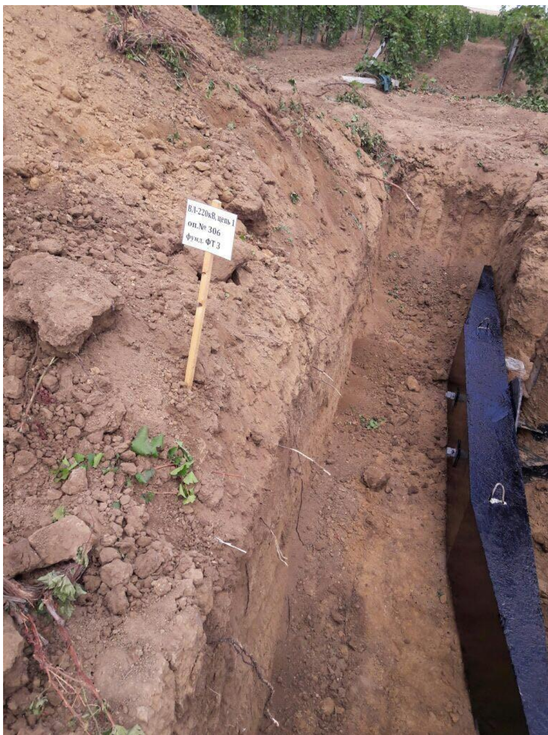
Рисунок 11 – Установка ригелей опоры ВЛ 220 кВ
